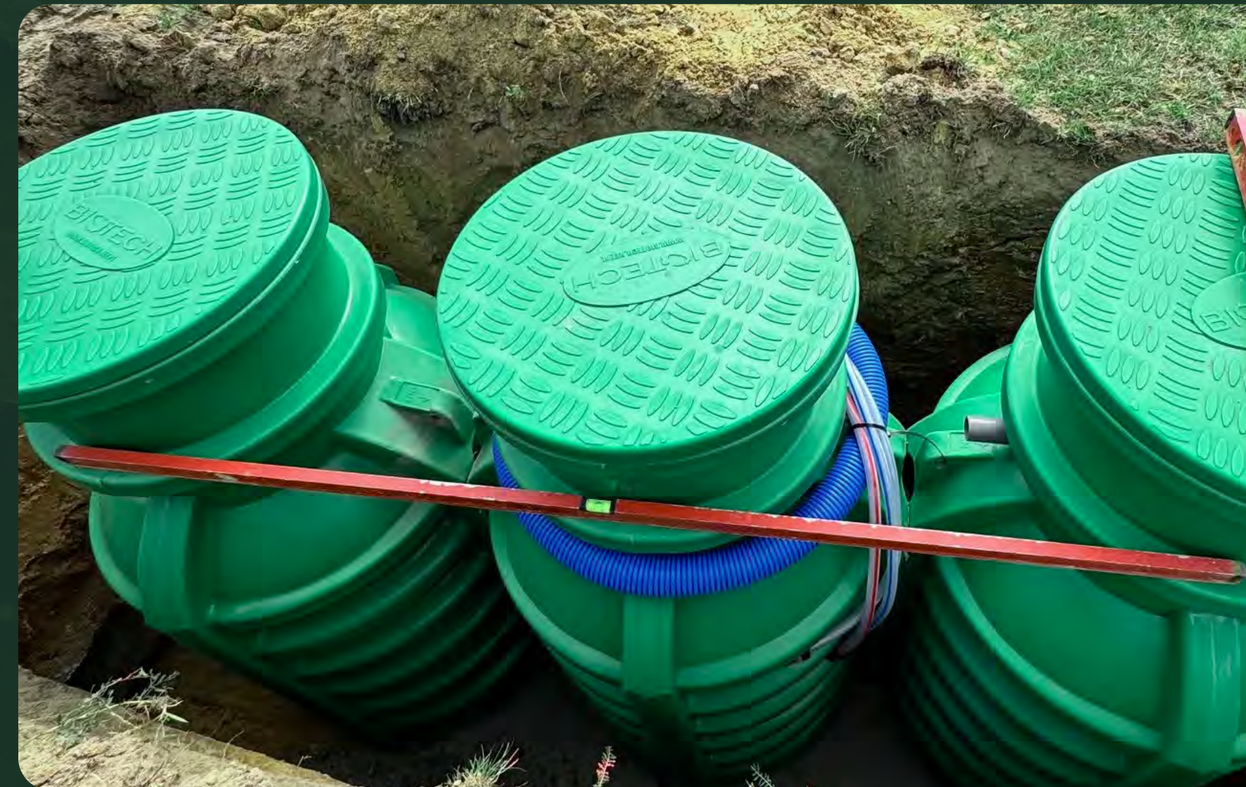
Oczyszczalnia biologiczna BIOTECH 6
