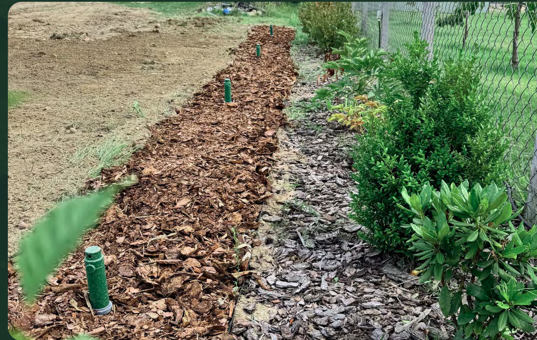
Oczyszczalnia biologiczna BIOTECH 6
