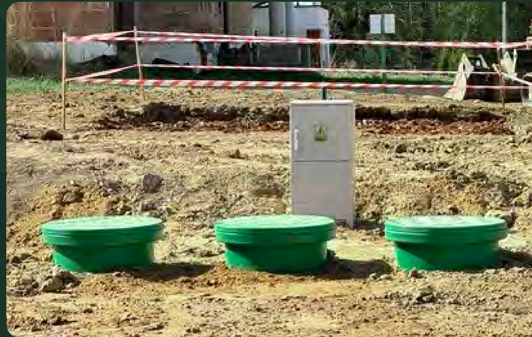
Oczyszczalnia biologiczna BIOTECH 6 IPS z poletkiem rozsączającym
