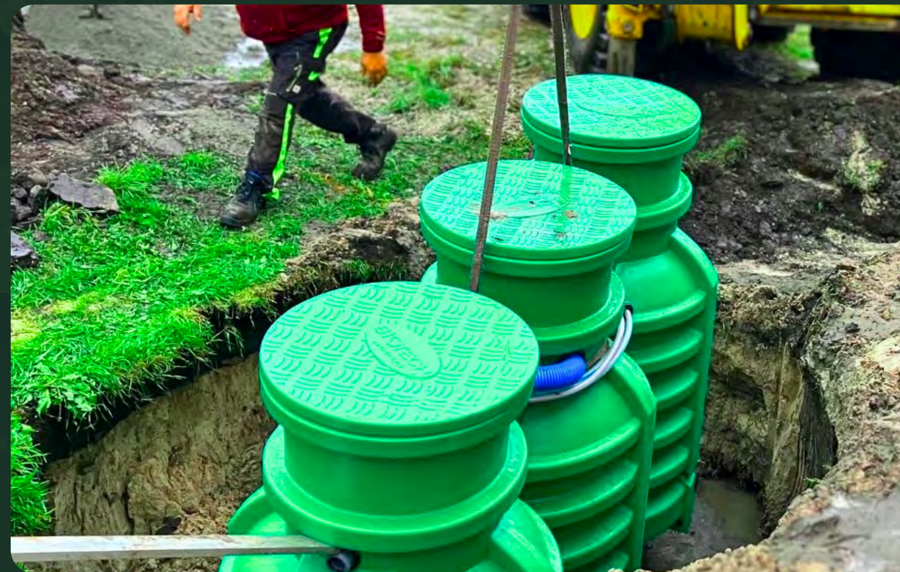
Oczyszczalnia biologiczna BIOTECH 6 IPS w ciężkich warunkach wodno-gruntowych
